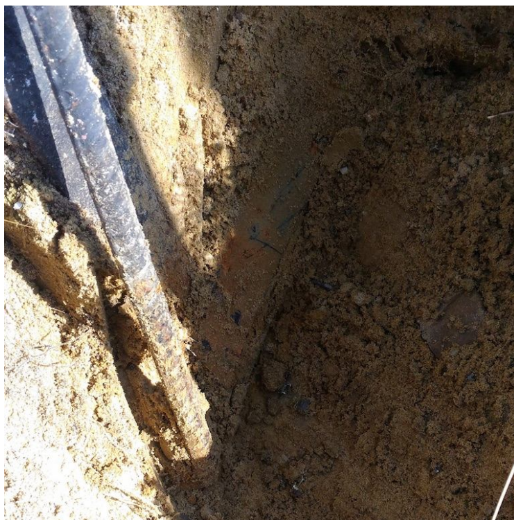
Рисунок 3 – Вскрытие грунта у заземляющих проводников
