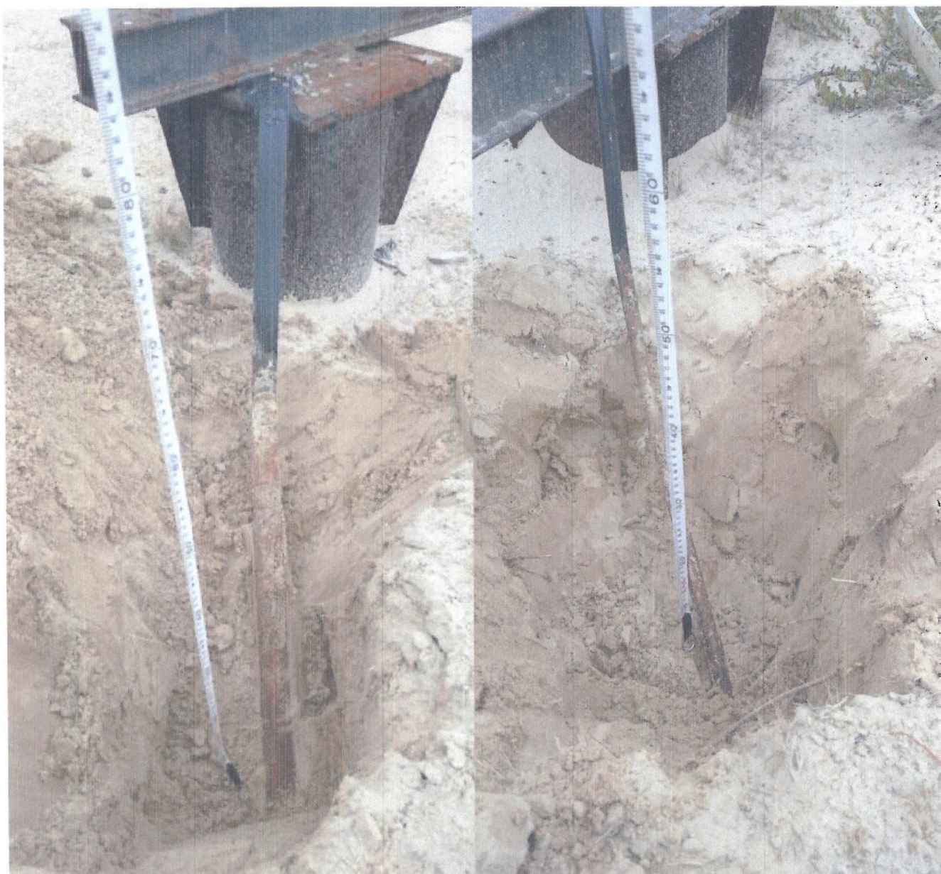
Рисунок 3 – Вскрытие грунта у заземляющих спусков
