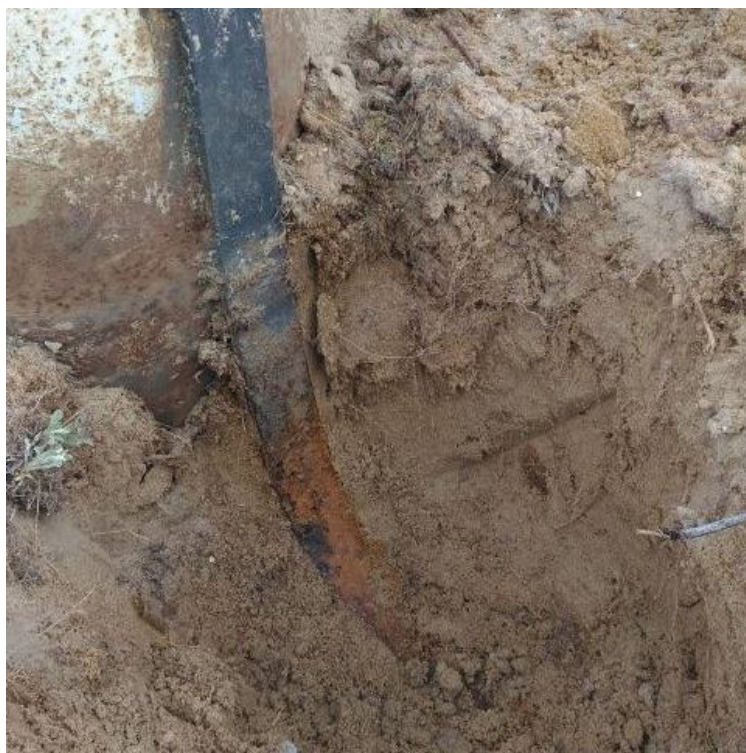
Рисунок 3 – Вскрытие грунта у заземляющих проводников
