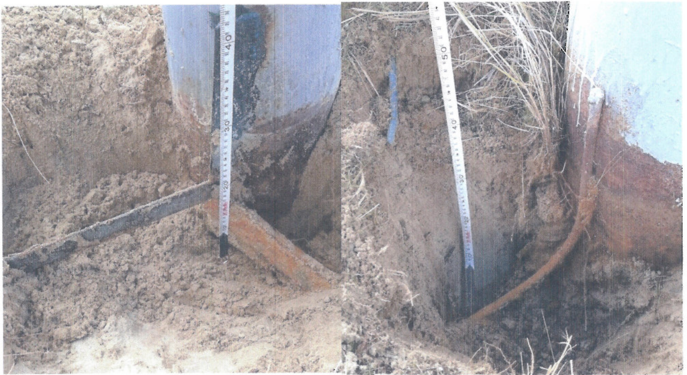
Рисунок 3 – Вскрытие грунта у заземляющих спусков
