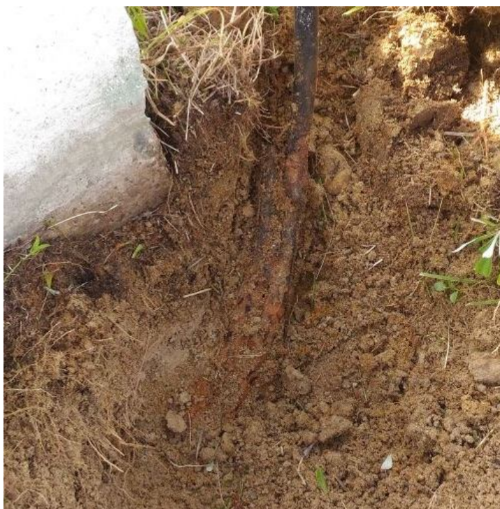
Рисунок 3 – Вскрытие грунта у заземляющих проводников
